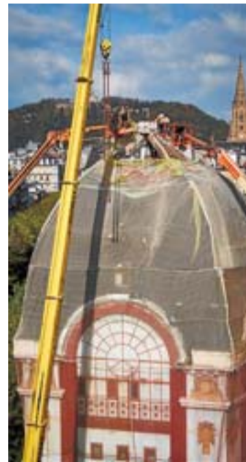
Desmontaje de la cúpula. :: USOZ
